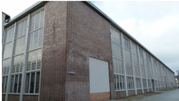
BILD 5. Dresden-Albertstadt, Turbomaschinen-Versuchs- und Montagehalle 1952/3, und bis 1945 Standort der 'Hochdruckfeldprüfanlage' (Brückner, Kanis & Co.)
