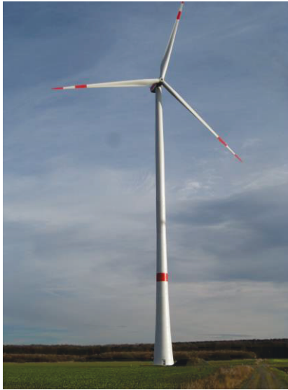
Bild 5. WEA 1 im Windpark Cramme Typ Nordex N117-2400; Gesamthöhe 199,5 m, Rotordurchmesser 117 m
