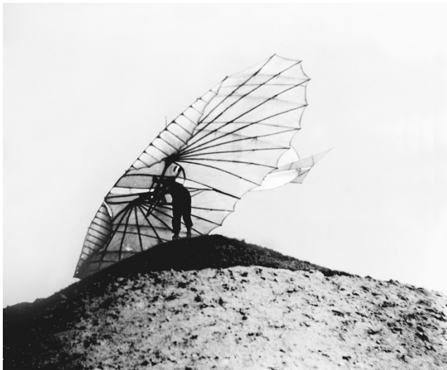
Bild 14. Das Experimentiergerät mit dem Vorflügel
