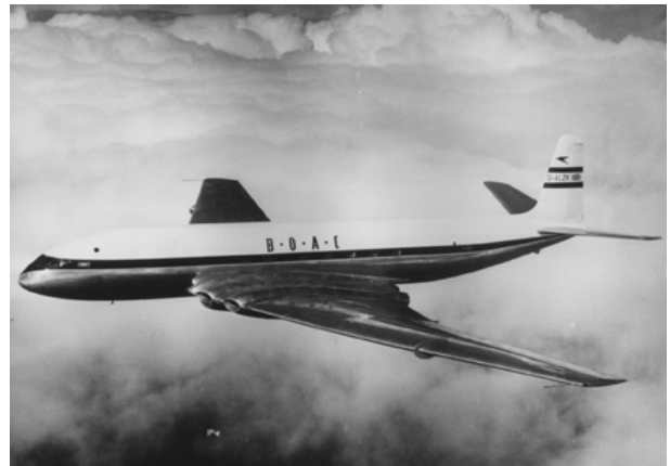
Abbildung 40: de Havilland DH 106 Comet. Erstflug: 27.09.1949, Einführung: 02.05.1952. Antrieb: 4 x de Havilland Ghost 50 Mk1 (Halford H2)
