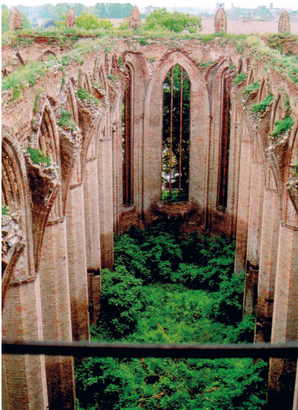
Zustand der Kirche 1993
